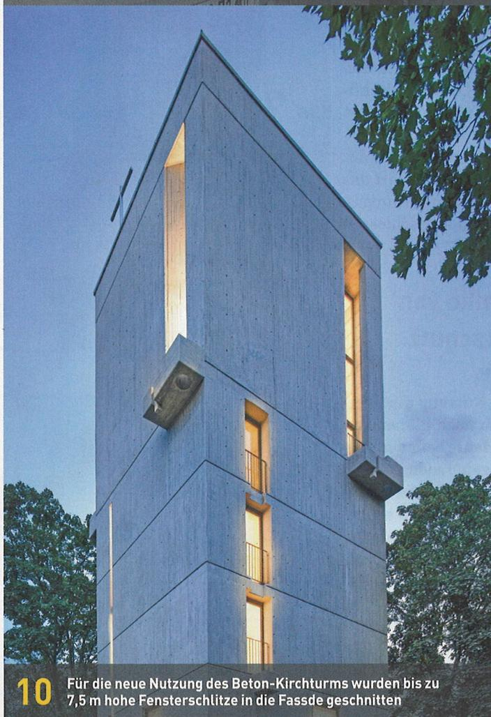
**10** Für die neue Nutzung des Beton-Kirchturms wurden bis zu 7,5 m hohe Fensterslitze in die Fassade geschnitten
